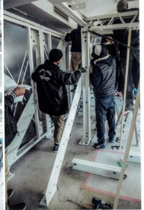
LGSパネルと同じ工場で作られたスチール製のフレームにステップを固定して、階段を製作していきます。ステップはロフト部分の床材と同じペーজのグレーチングを使用することに。まず、フレームにステップを固定するためのプレート装着。その後、ステップを置いて水平を確認しながら一個一個ボルト&ナットで留めていきます。
