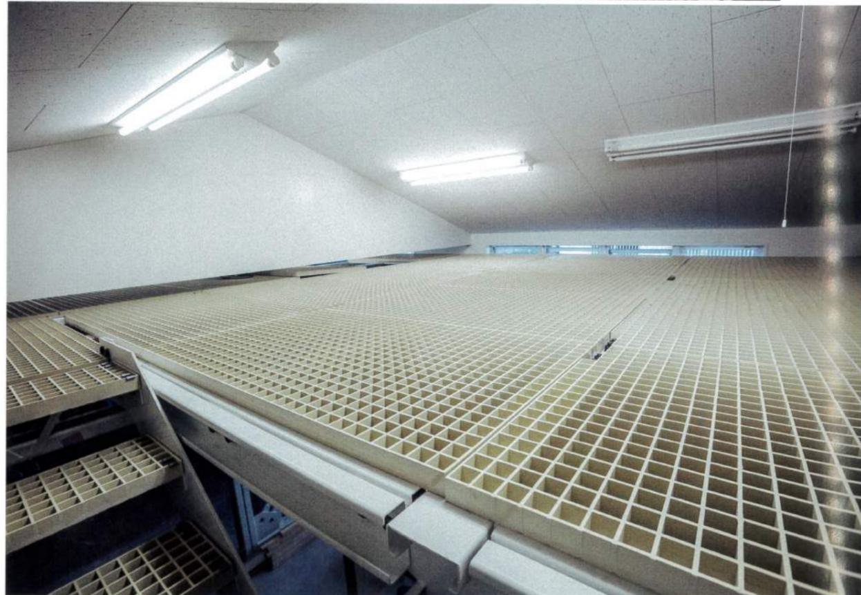
グレーチングが敷き詰められ完成したロフト部分。天井までの高さは一番高いところで1メートル20センチほど。床面積は約30㎡ほどなので、相当な量の荷物を収容可能となりました。出っ張った蛍光灯は邪魔なので、天井に埋め込めるスポットライトに変更します。
