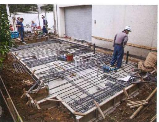
鉄筋を張り巡らせ、LGS/パネルと基礎の接合部となるボルト位置も全て決定。最後に生コンを流し込んで乾燥させたら基礎は完成。ページをめくると、いよいよ骨格の作業が始まります。
