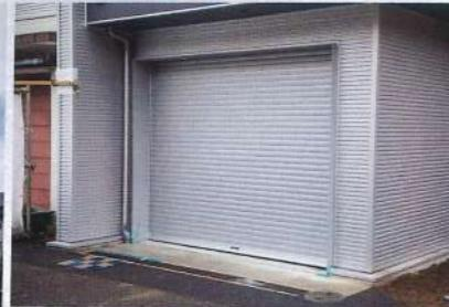
外壁に合わせてシャッターもシルバーに。母屋ではオーバースライダー式を採用していますが、それだと、天井に沿ってシャッターが上がってしまうので、せっかく露出させた天井の骨格にモノをつり下げたりするコトができないなってします。なので、増築部分のシャッターは巻き上げ式に。サイドビューは、ラウンドした屋根と外階段&ベランダのバランスが良い感じ。
