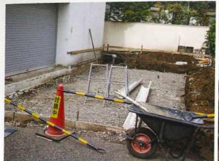
家が建つ部分を深く掘って、基礎を作る準備。先に取り外した下水と雨水の配管は増築される部分を避けて、建物の脇を通るように埋設しました。グレーの砂利が敷き詰められた部分が基礎を作る場所となります。
