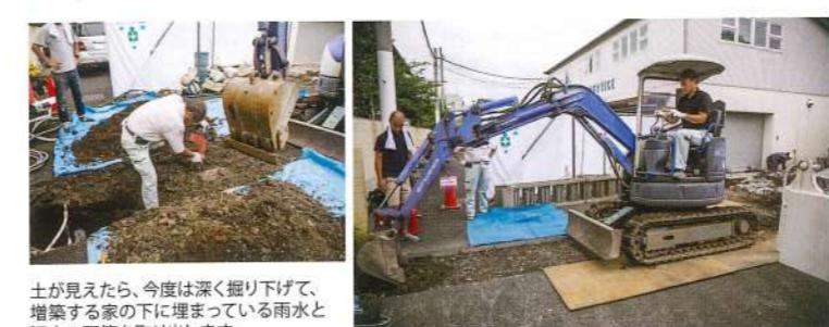
土が見えたら、今度は深く掘り下げて、増築する家の下に埋まっている雨水と汚水の配管を取り出します。
