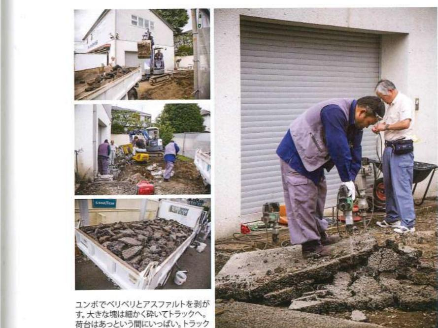
ユンボでベリベリとアスファルトを剥がす。大きな塊は細かく砕いてトラックへ。荷台はあっという間にいっぱい。トラック2台分のアスファルトを撤去完了です。
