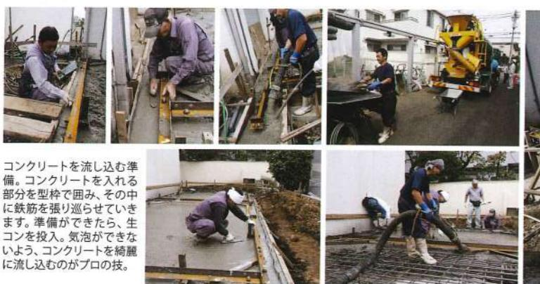
コンクリートを流し込む準備。コンクリートを入れる部分を型枠で囲み、その中に鉄筋を張り巡らせておきます。準備ができたら、生コンを投入。気泡ができるないように、コンクリートを綺麗に流し込むのがプロの技。
