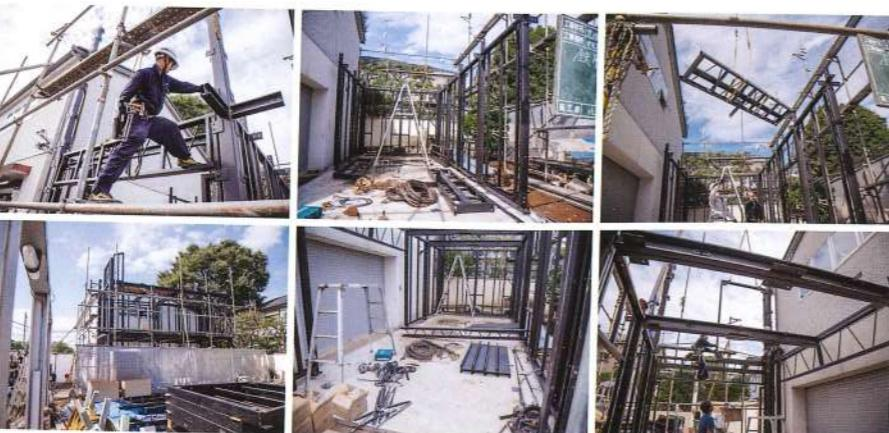
図面通りに設計されたパネルをひたすら順番にパズルのようにはめ込んでいく作業。現場での加工はほとんど無いので、組み立てに掛かる時間はとても短いです。なんと、骨格の立て込みに掛かった時間は約2日。短期間で施工できてしまうというのも、デイトナハウスの良いところ。
