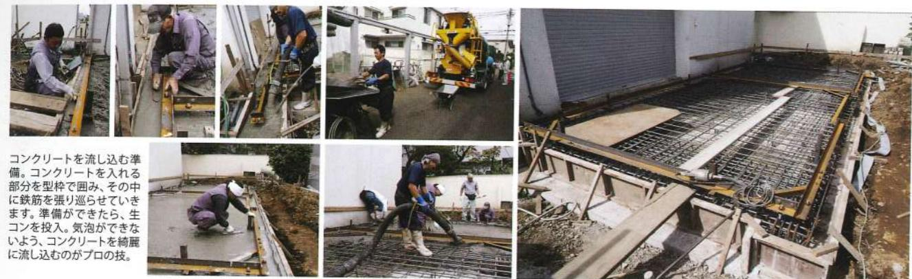
コンクリートを流し込む準備。コンクリートを入れる部分を型枠で囲み、その中に鉄筋を張り巡らせていきます。準備ができたら、生コンを投入。気泡ができるよう、コンクリートを綺麗に流し込むのがプロの技。
