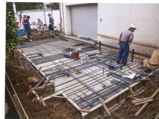
鉄筋を張り巡らせ、LGSパネルと基礎の接合部となるボルト位置も全て決定。最後に生コンを流し込んで乾燥させたら基礎は完成。ページをめくると、いよいよ骨格の作業が始まります。
