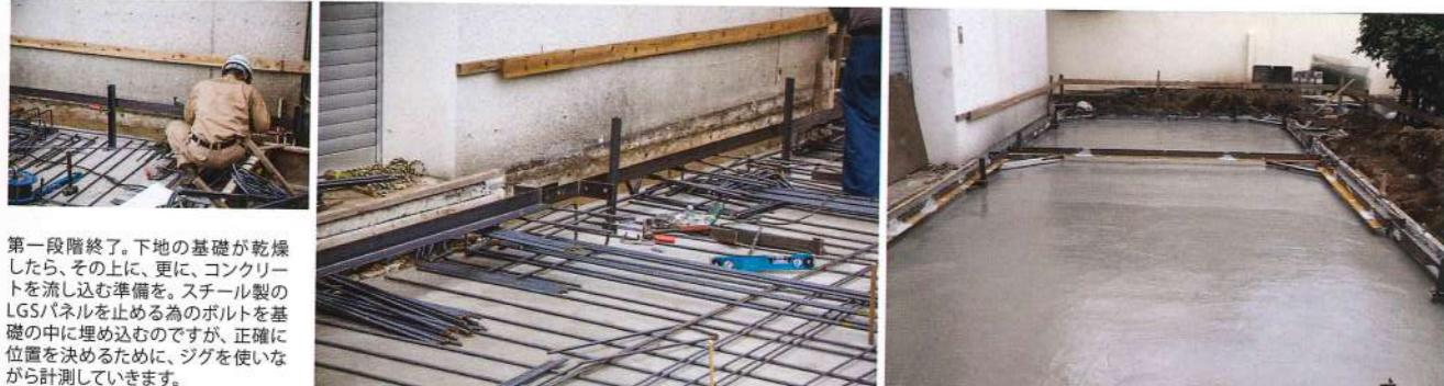
第一段階終了。下地の基礎が乾燥したら、その上に、更に、コンクリートを流し込む準備を。スチール製のLGSパネルを止める為のボルトを基礎の中に埋め込むのですが、正確に位置を決めるために、ジグを使いながら計測していきます。
