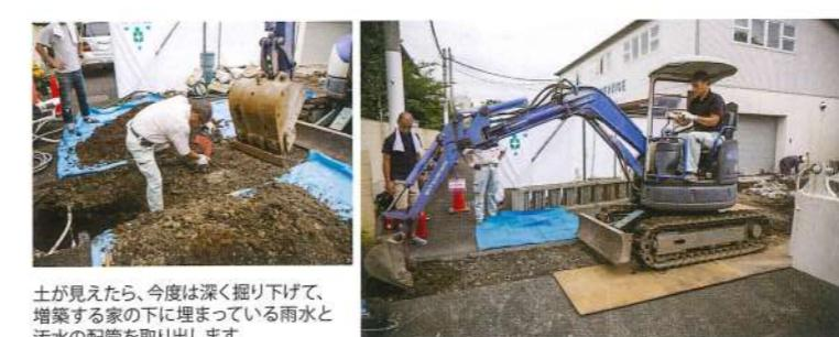
土が見えたら、今度は深く掘り下げて、増築する家の下に埋まっている雨水と汚水の配管を取り出します。
