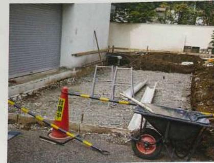
家の建つ部分を深く掘って、基礎を作る準備。先に取り外した下水と雨水の配管は増築される部分を避けて、建物の脇を通るように埋設しました。グレーの砂利が敷き詰められた部分が基礎を作る場所となります。
