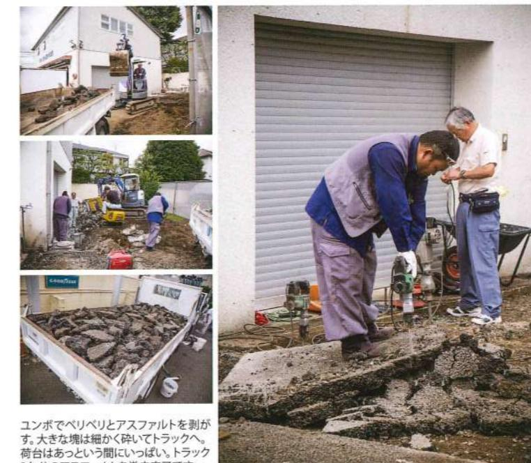
ユンボでペリペリとアスファルトを剥がす。大きな塊は細かく碎いてトラックへ。荷台はあっという間にいっぱい。トラック2台分のアスファルトを撤去完了です。
