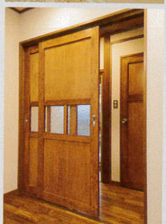
古色を加え、波板ガラスを入れた引き戸
