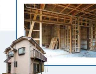
1986年度という古物件をベースに、壁を抜いてインナーガレージを作成。かがみ窓を設置。床の調査解体の結果、いけると判断。間取り変更と断熱層を盛り込んだ床面も施工。それに伴い見積り額金も確定。なかなかの金額に怯えつつ地元信金のドアを叩いた。
