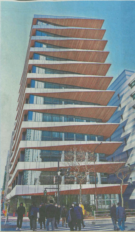
木材を使った外観が目を引く銀泉西新橋ビル。いずれも港区で
