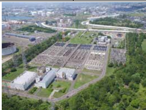
仙塩浄化センター（遠景）
